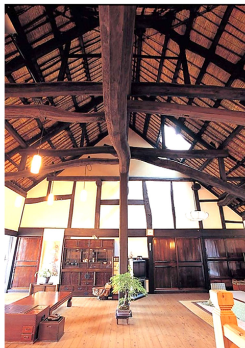
土間空間の梁柱とドマ境壁に建つ曲がった柱 撮影: 舟住一夫
